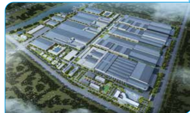
2023年2月8日，中国巨石淮安涟水玻璃纤维零碳智能制造基地奠基暨一期项目正式开工
