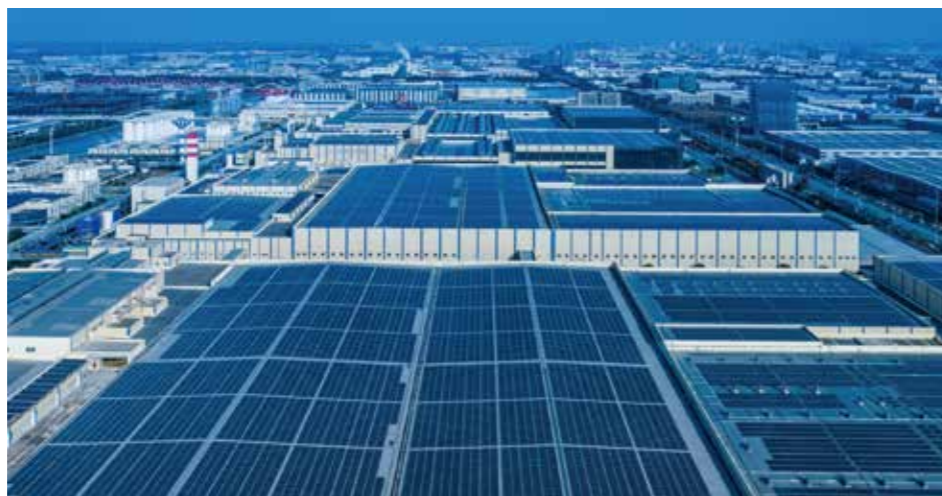
桐乡60万平方米的屋顶，实现太阳能光伏板全覆盖公司，每年发电近7000万千瓦时，并全部用于生产。
