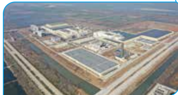
2022年5月28日，中国巨石举行九江智能制造基地一期项目开工仪式
